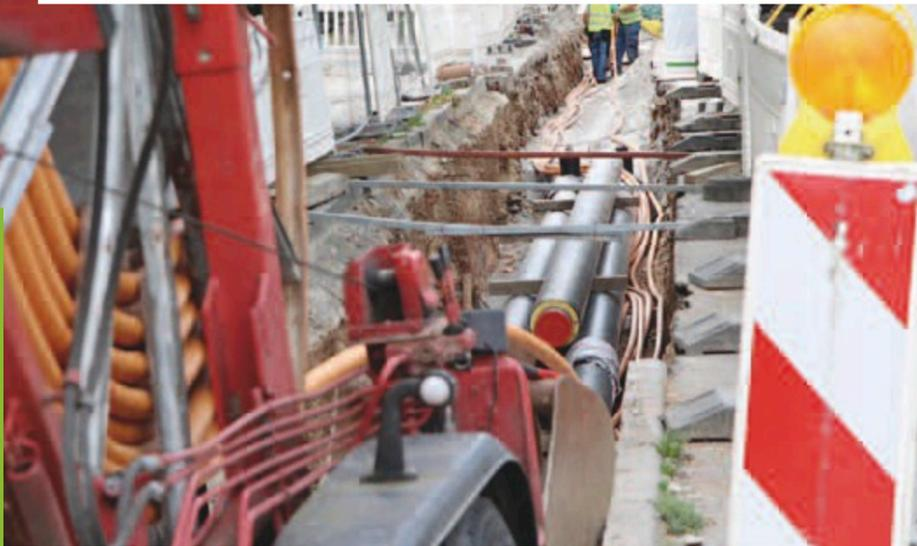
Zusammen mit neuen Fernwärmeleitungen wurden im Barbara-Uthmann-Ring kürzlich Datenkabel verlegt. Foto unten: Installateur- und Klempnermeister Enrico Estel: „Der Breitbandanschluss funktioniert super.“
